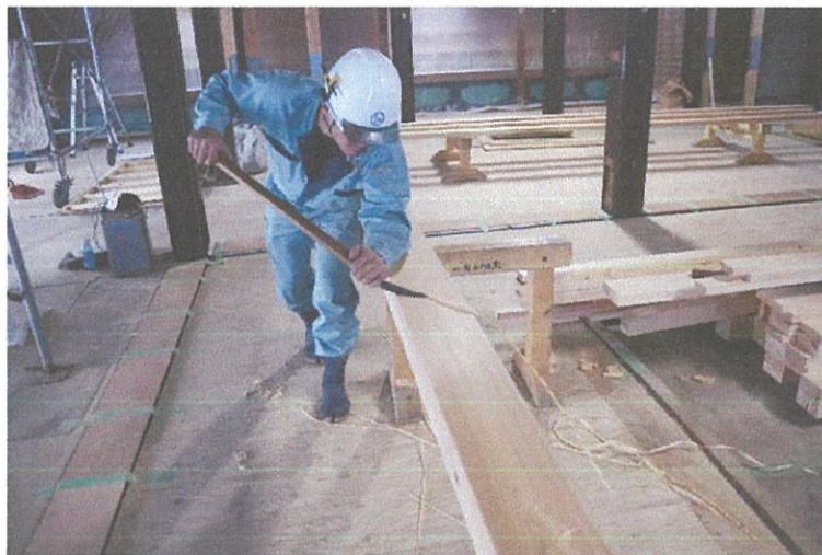
古式の木工技術による修理の様子
