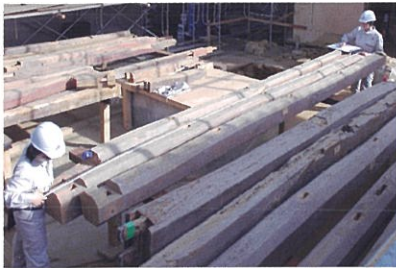
1 建造物修理 2 建造物木工 [部材実測調査]
