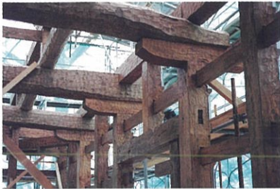
2 建造物木工 [城櫓施工状況]
