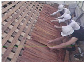
(公社)全国社寺等屋根工事技術保存会
