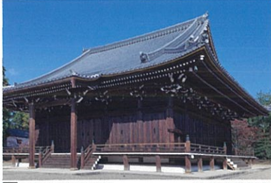
11 屋根瓦葺(本瓦葺) [仁和寺観音堂]
