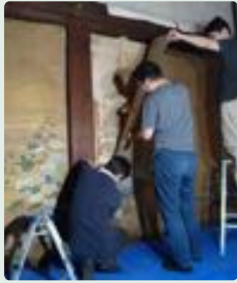
たてもの かべはりつけ しょうへきが と はず さぎょう きょうとし にじょうじょうにのまるごてん 建物から壁貼付(障壁画)を取り外す作業(京都市 二条城二之丸御殿)
